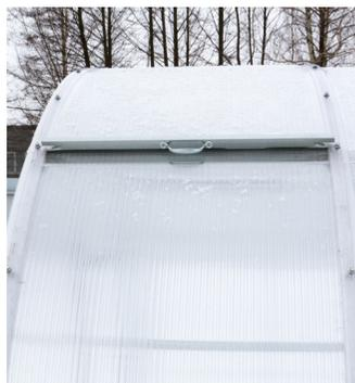
Панель сдвижная предназначена для проветривания теплицы и исключения снеговой нагрузки на каркас теплицы. Сдвигается при помощи удобной ручки в одну или другую сторону по всей высоте теплицы.
